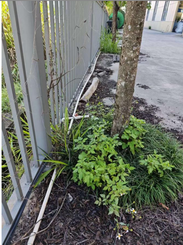
生活污水绿化灌溉口
